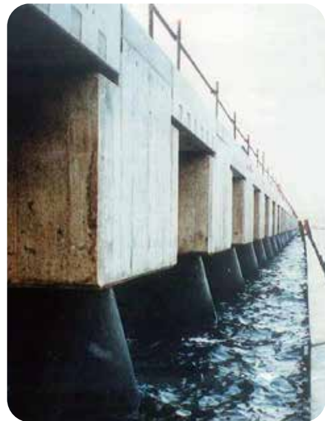
東京電力株式会社 柏崎刈羽原子力発電所 南側取水口ジャケット 1984年施工
