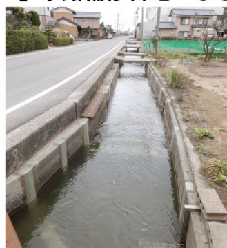
大型フリューム目地補修
