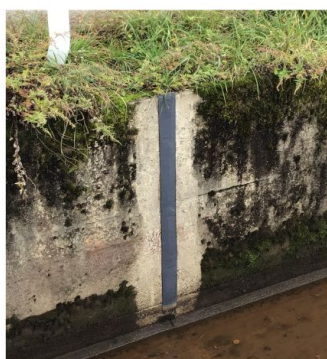
現場打ち水路（黒色）
